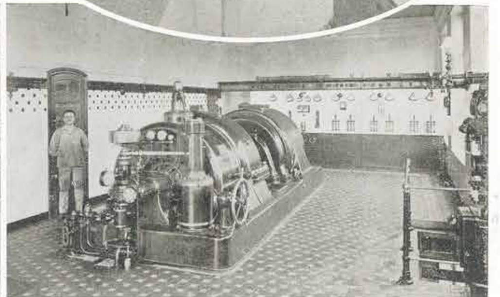
Dans l'ovale: De la centrale électrique, ils ne laissèrent que le tableau de marbre, complètement dépouillé de ses appareils. En bas: La centrale électrique de 2.500 HP en plein fonctionnement.
