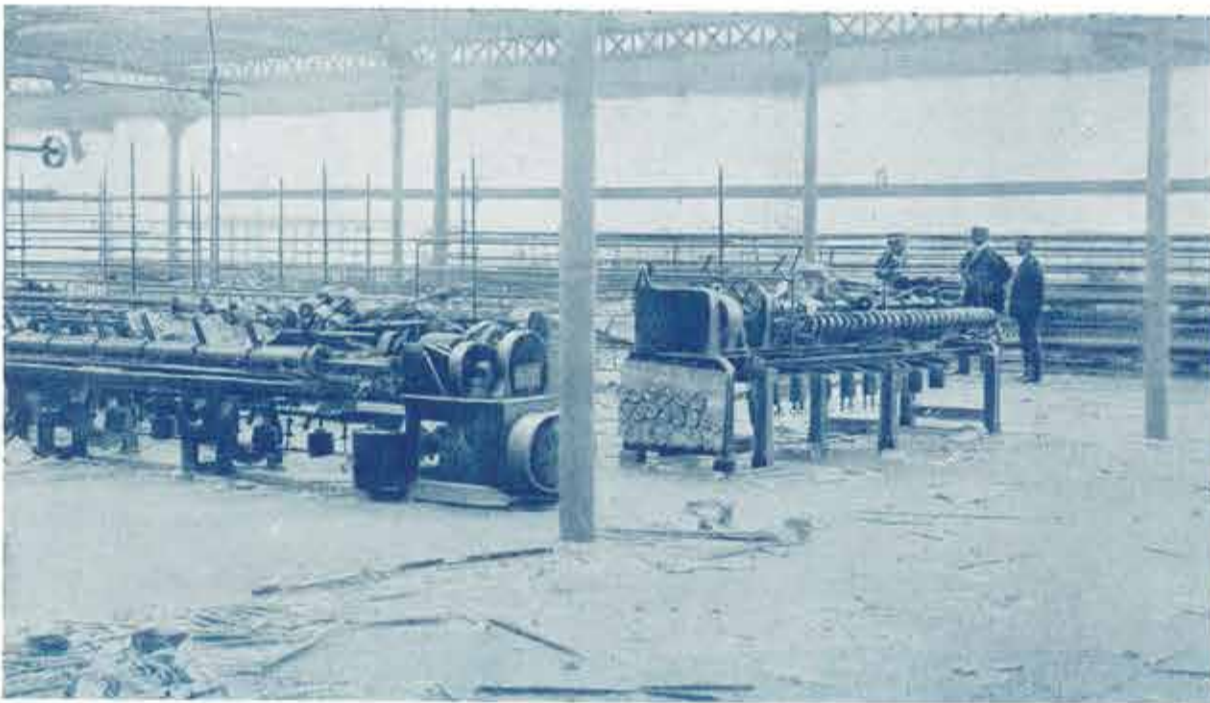
Une salle de préparation en cours de destruction
