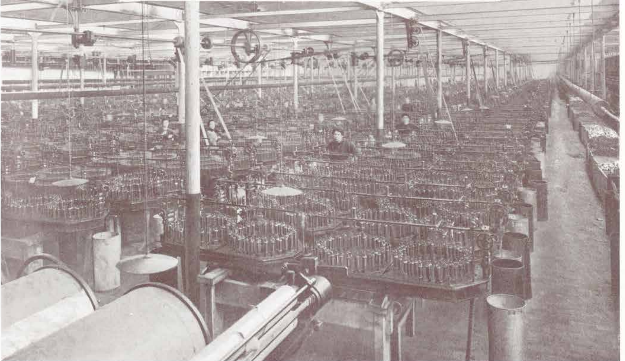
En haut: Salle de machines dynamitée — En bas: Salle de tissage reconstruite.
