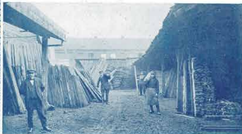
Chantier de la rue Rossini.
