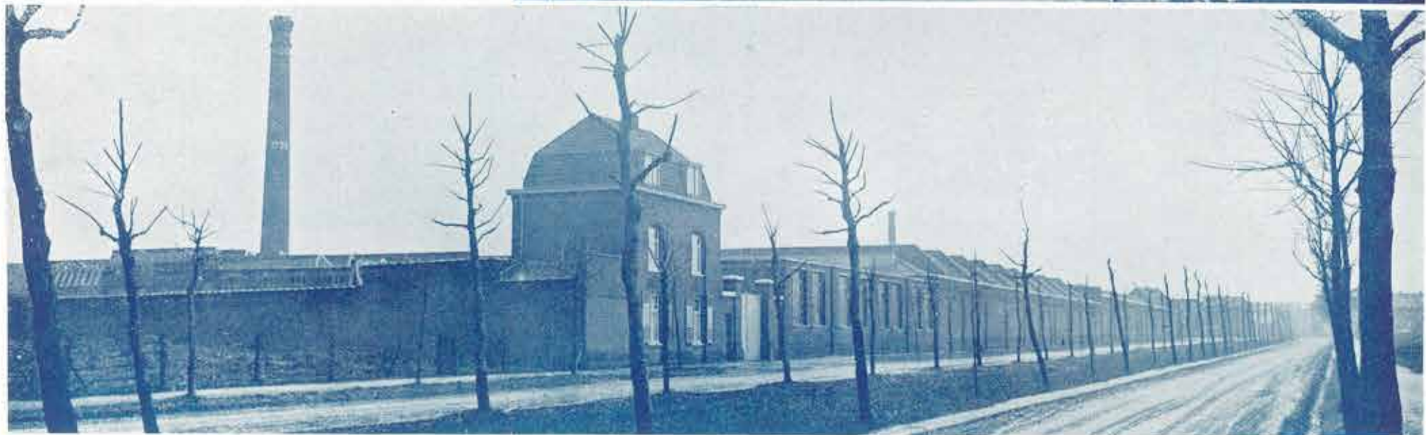
En haut: la filature. Cet atelier présente quelques particularités, entre autres tous les métiers sont actionnés par une transmission accouplée directement au moteur. Les pertes d'énergie sont ainsi réduites au minimum. — En bas: l'usine Catteau-Lorthiois, à Tourcoing.
