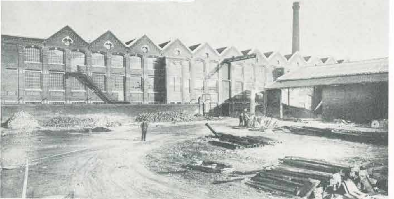
La nouvelle façade de l'usine de Mouvaux.
