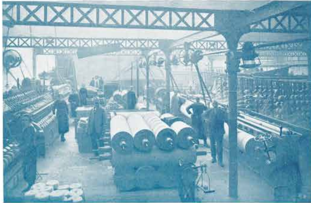
Une salle de préparation.
