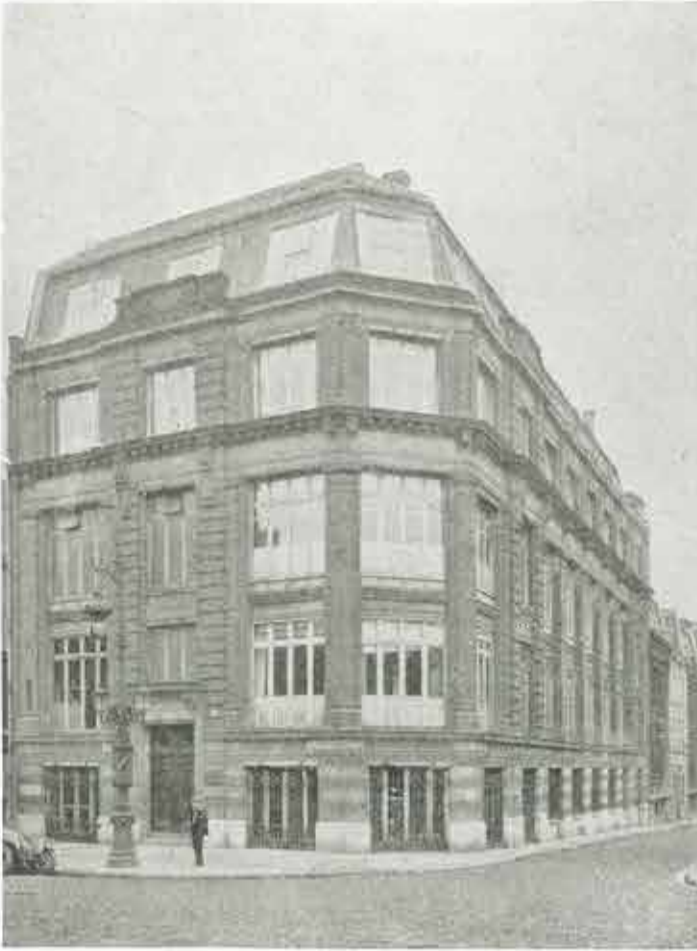
Entrée des Bureaux.
