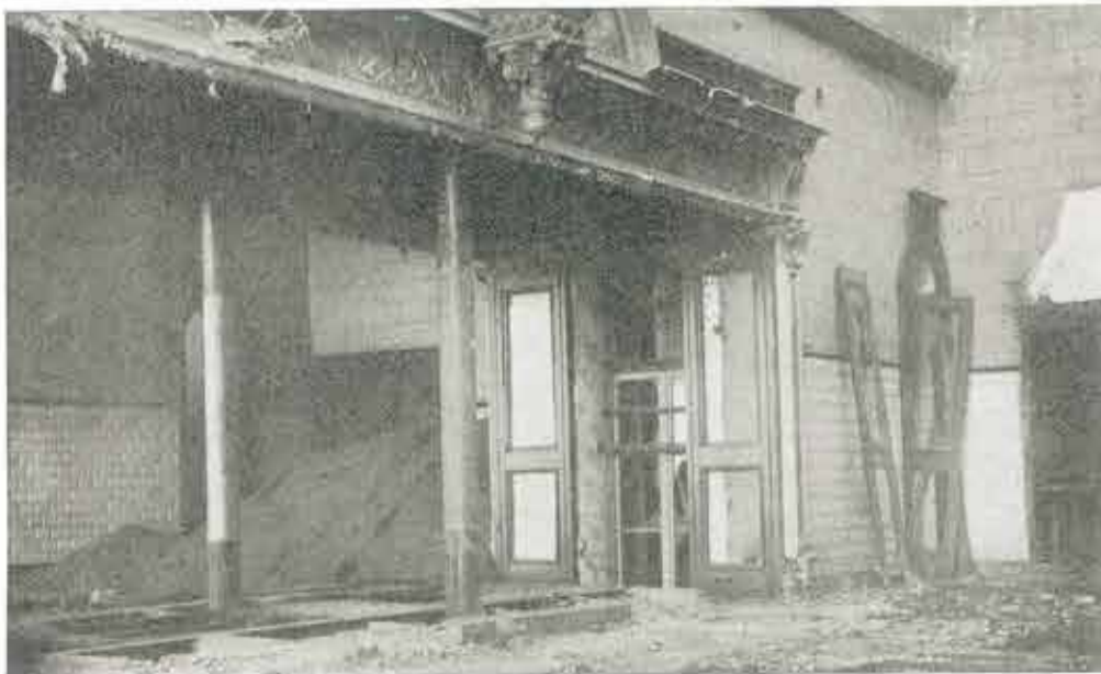
L'ancienne salle des turbines.
