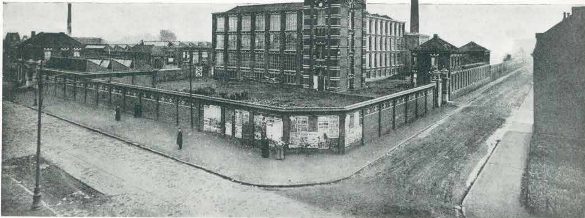
Vue générale de l'usine.
