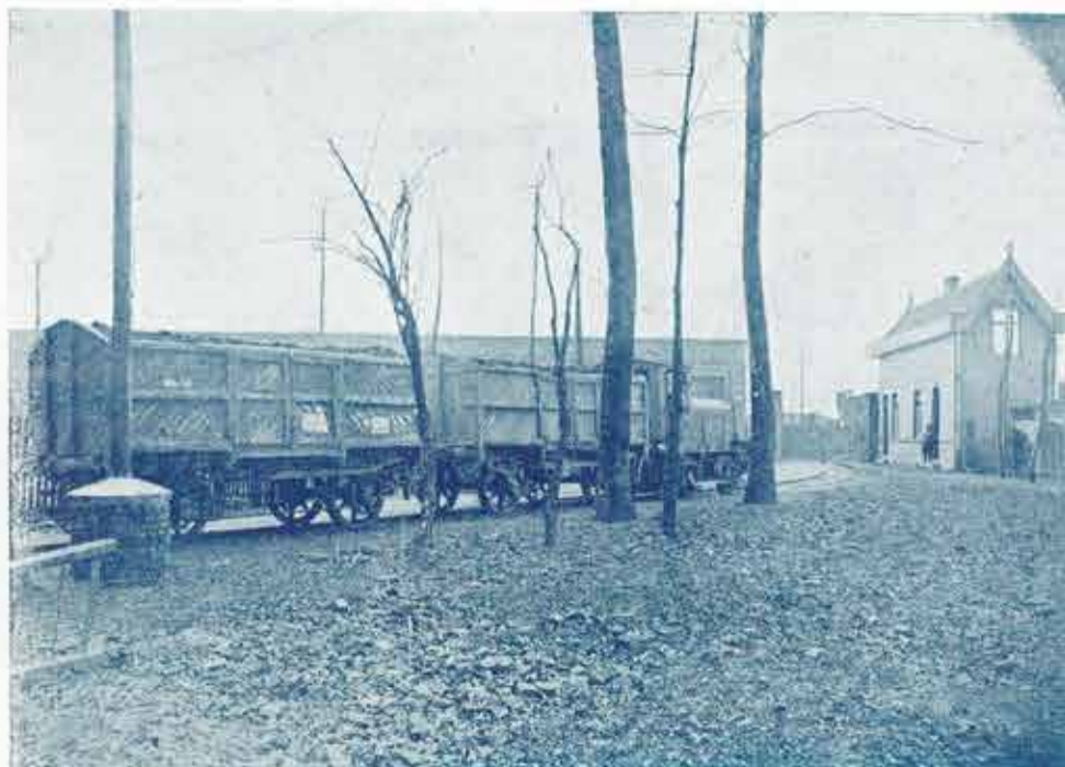
L'embranchement de l'Usine Boutemy. Derrière, on aperçoit le commencement des vastes magasins généraux qui servirent de dépôt de munitions aux Allemands.
