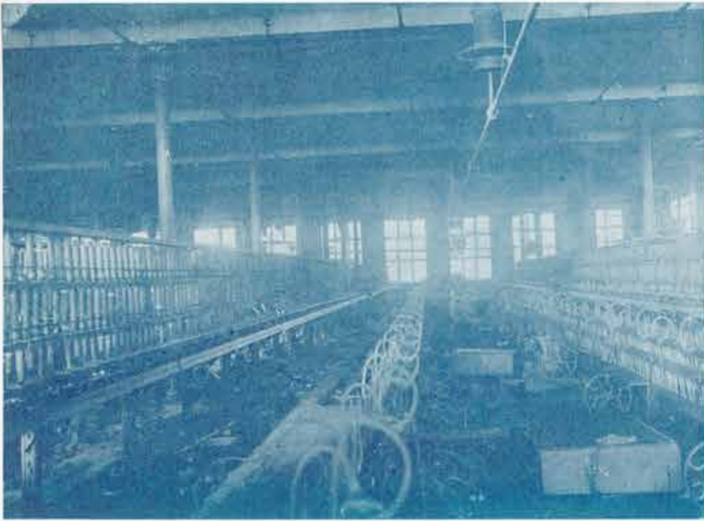
Les renvideurs complètement tordus et démolis.
