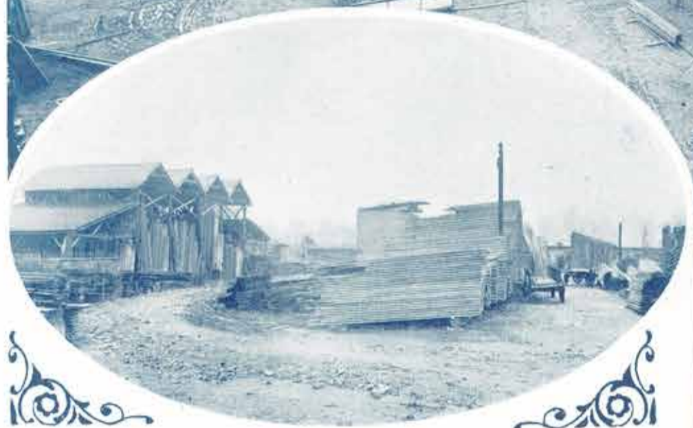
Vue générale des chantiers de Roubaix. — Dans l'ovale, les chantiers de Lille.
