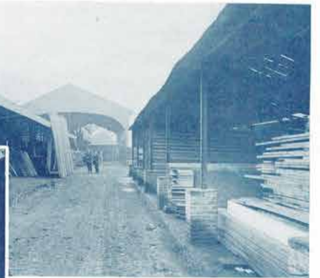
Chantier de la rue Meyerbeer.
