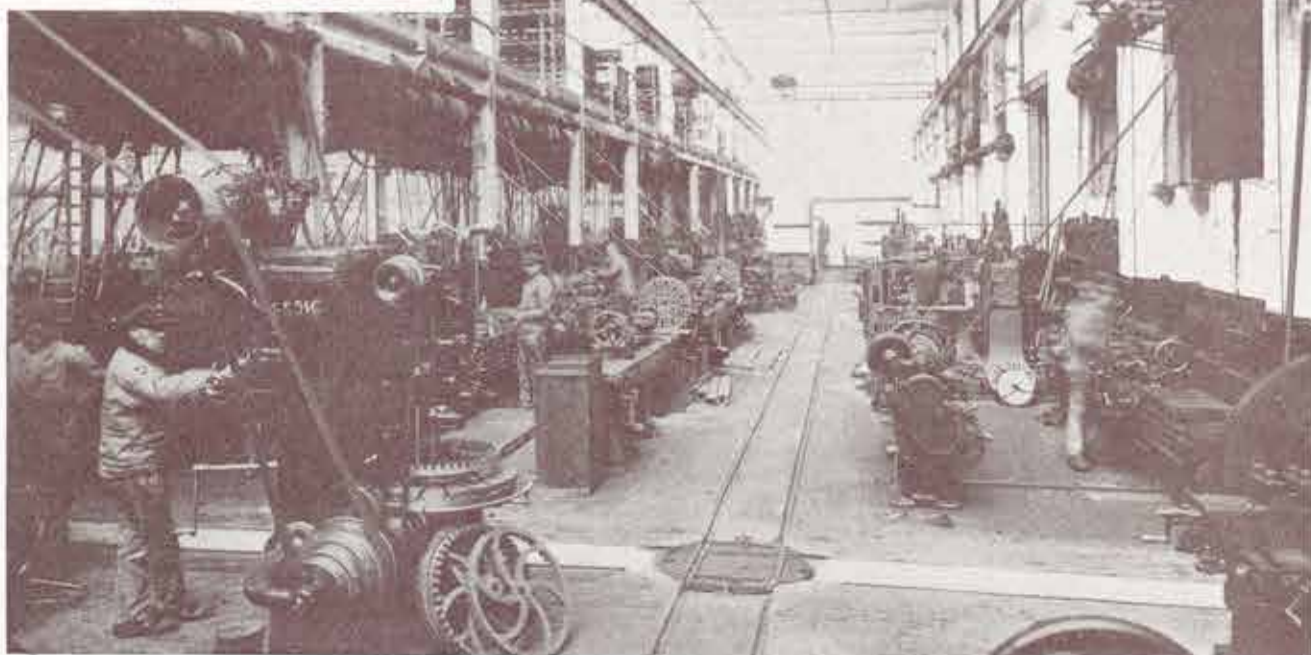
Les ateliers dans leur état actuel.
