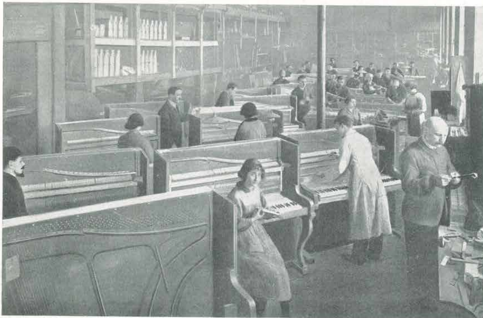
Salle de finition de l'usine Coupleux, frères à Tourcoing.
