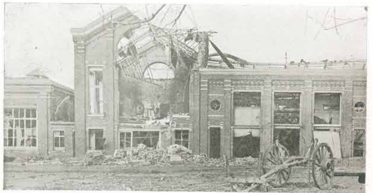
La machine à vapeur et les générateurs volontairement dynamités.
