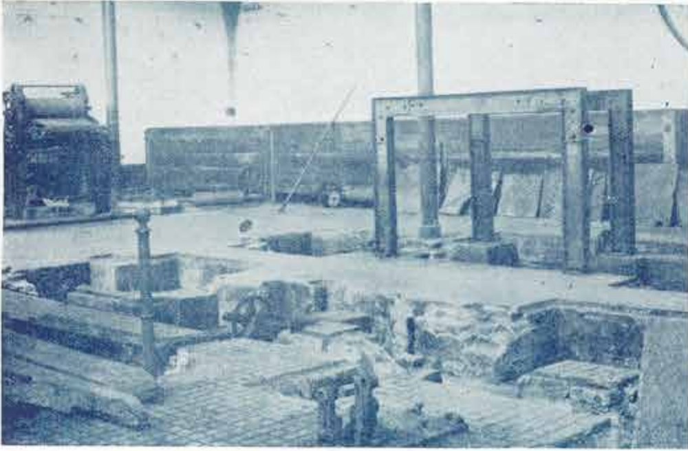
La salle des grands appareils à teindre, détruite.
